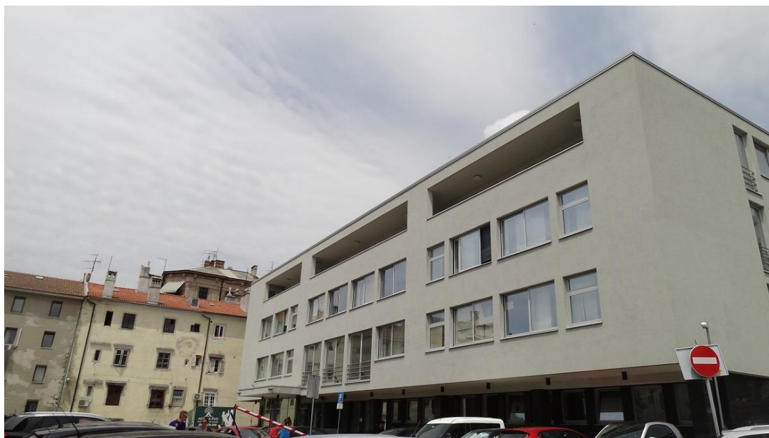
Slika 2. Pogled na južno pročelje
