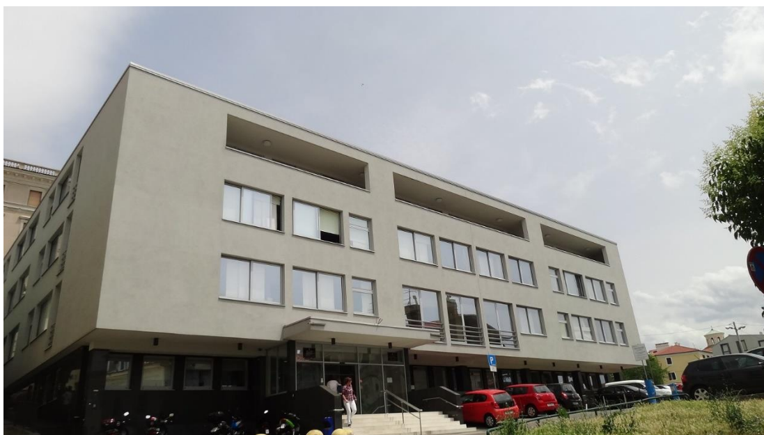
Slika 1. Pogled na južno pročelje
